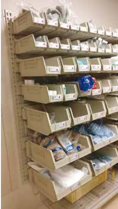
Shramba za potrošni material s posodami, ki se stalno tehtajo. Teže se ves čas sporočajo v osrednji računalnik.
